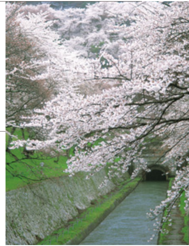
大津運河の桜。第一トンネル東口を遠望する。 (写真提供/びわこビジターズビューロー)
