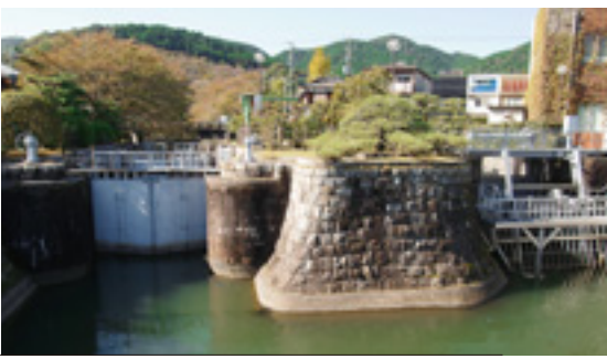
北国(ほっこく)橋と鹿閑(かぜき)橋の間にある 制水門(右)と閘門(左)。制水門で水量を調節し、 流量を安定させている。
