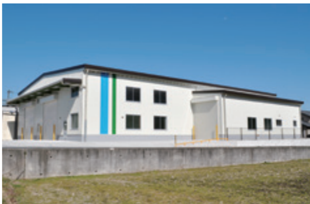
ラチス構造に鋼板を使った、高い耐久性の「プレハウス」
