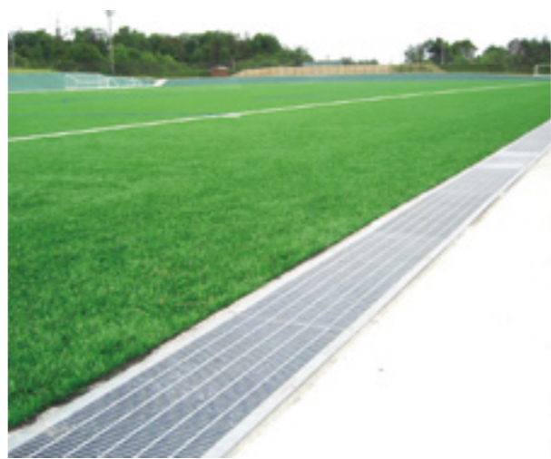
ハイテングレーチングの施工例
