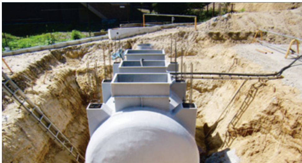
浄化槽施工の現場
