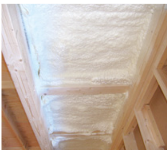
硬質ウレタンフォームを水発砲で吹き付ける断熱材「アクアフォーム」
