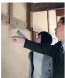
櫓の中の壁は、床から2mほどを境に上部は薄く、下部は厚く造られている。敵の銃弾が人の高さのところまでは壁を貫通しないようにする工夫である。
