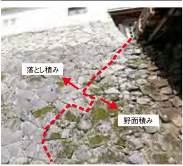
天秤槽の石垣は、廊下橋を境にして東側と西側では石垣の積み方が異なります。東側の積み方が、自然の石をそのまま用いて積み上げる「野面積み」。西側は石を下方に落とし込んで積み上げる十九世紀の技術「落とし積み」が施されています。長い年月の間に、何度も修理が重ねられたことが分かります。
