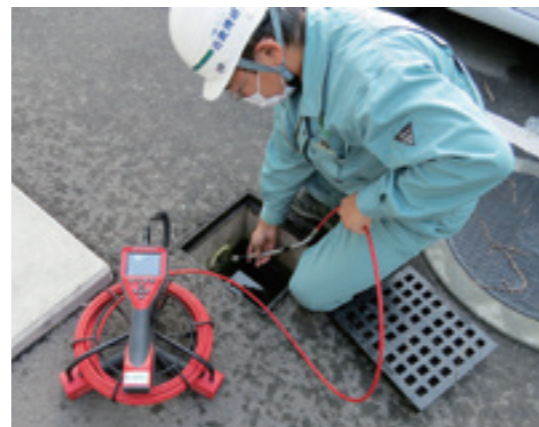
工業用内視鏡を用いて配管内の検査を行う
