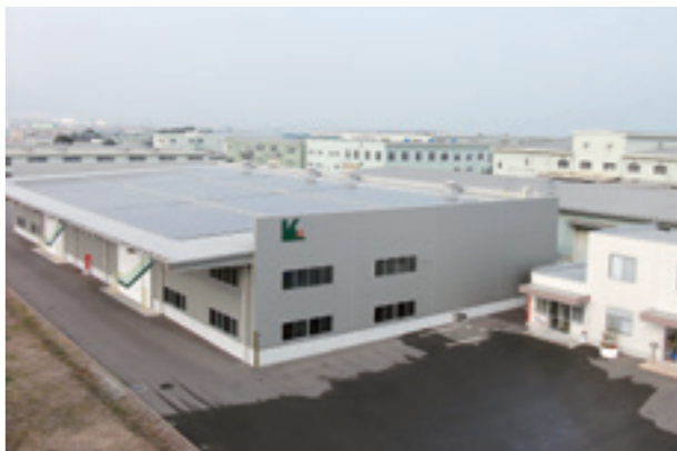
2009年開設の福岡事業所。工場のメンテナンスから倉庫まで一体となり推進されている
