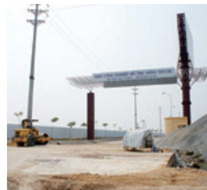
工事が進められるドンヴァンIII工業団地
