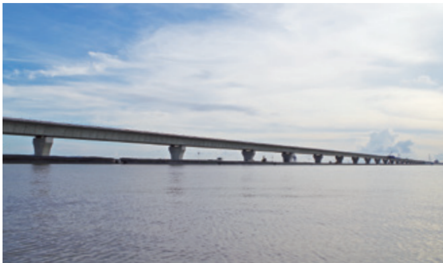
多くの免震支承が使われたラックフェン国際港アクセス道路（ベトナム）
