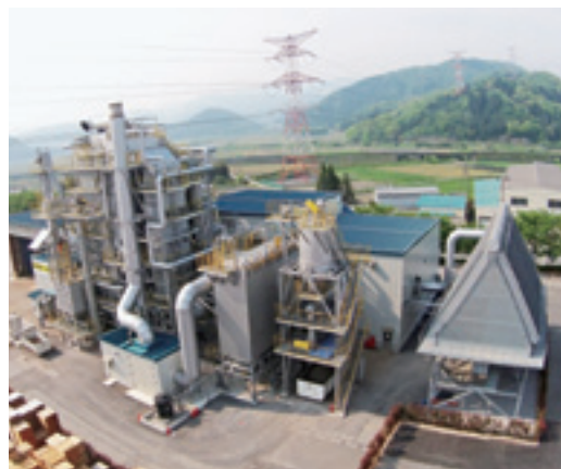
毎時3,550キロワットの発電能力を持つ「木質バイオマス発電所」
