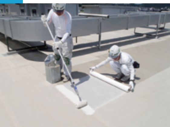
屋上の防水工事
