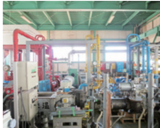
同社製品が生まれる技術研究所内の配管設備
