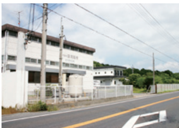
最新の製粉と菓子製造設備を誇る野洲市の近江富士工場
