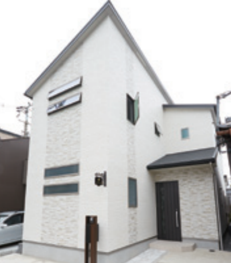
施工事例の外観
