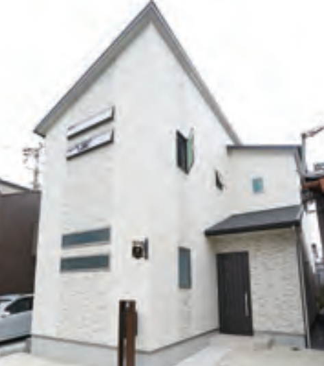
施工事例の外観
