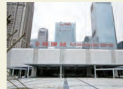
新しく開業した福田駅
