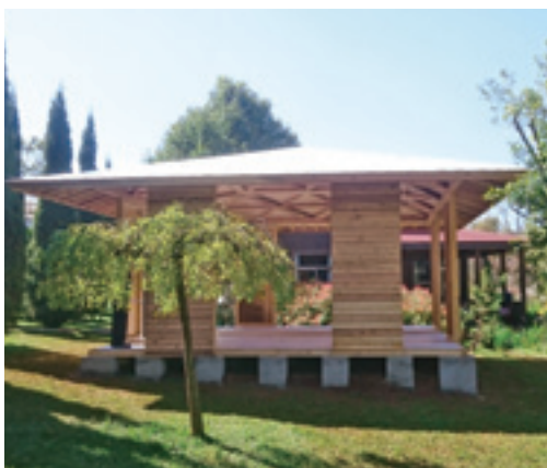
中国昆明に建築したユニットハウス
