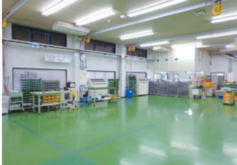
クラス1万を確保しているクリーンルーム
