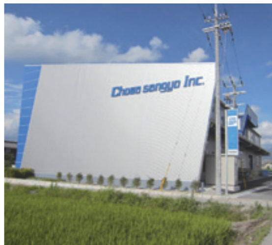
環境に配慮した2013年竣工の新工場
