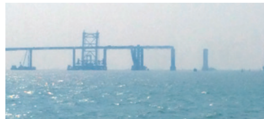
香港・珠海・マカオを結ぶ「港珠澳大橋」の建設現場。急ピッチで工事は進むが、香港にとっての「夢の架け橋」になり得るのだろうか
