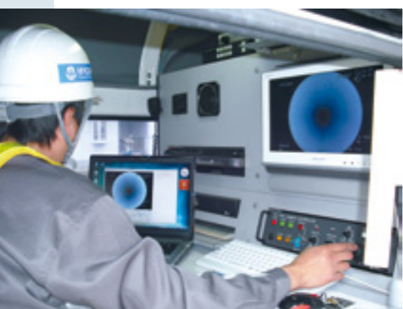
下水道管路TVカメラ調査
