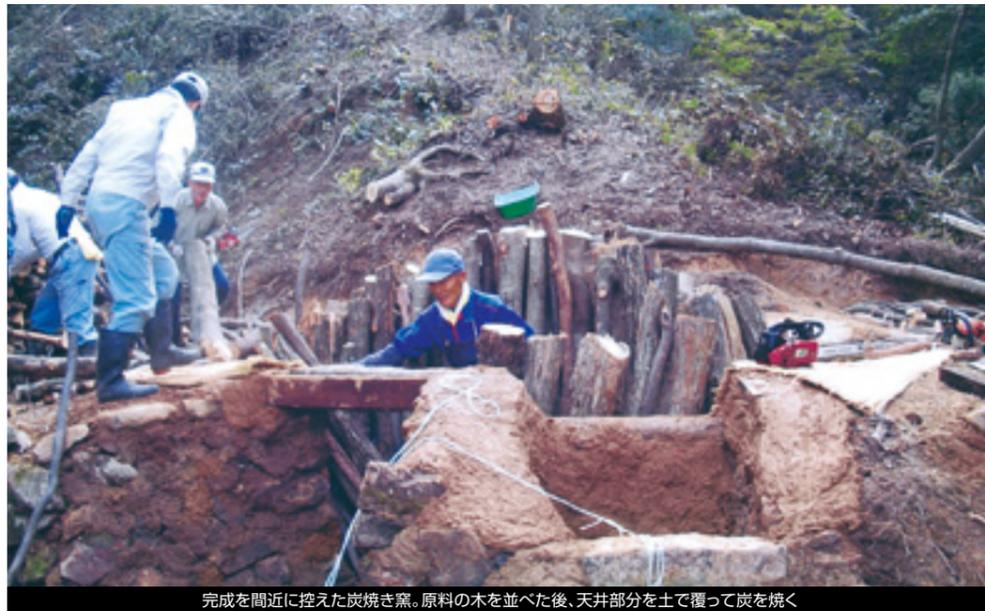
完成を間近に控えた炭焼き窯。原料の木を並べた後、天井部分を土で覆って炭を焼く
