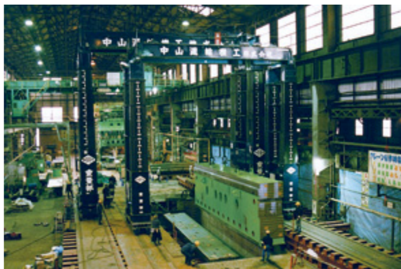
「スーパーリフター」による1万2千トンプレス材の据え付け工事
