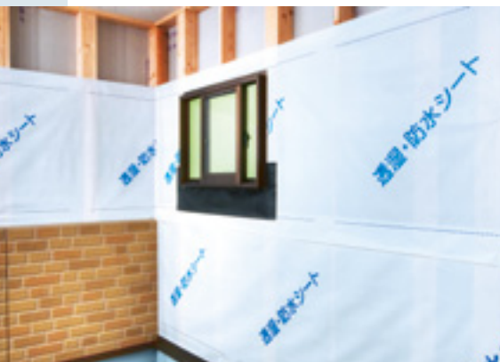
多孔質フィルムと不織布を貼り合わせた透湿防水シート 「ハウスラップ」
