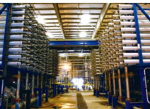
RO(逆浸透)膜によるトリニダード・トバゴの海水淡水化プラント
