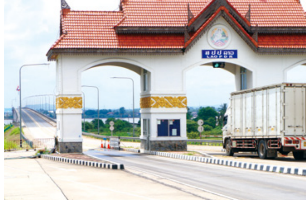
東西経済回廊の第2メコン友好橋
