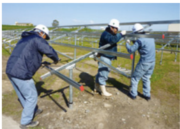
さまざまな工夫が凝らされた遊休地での太陽光発電パネルの設置工事
