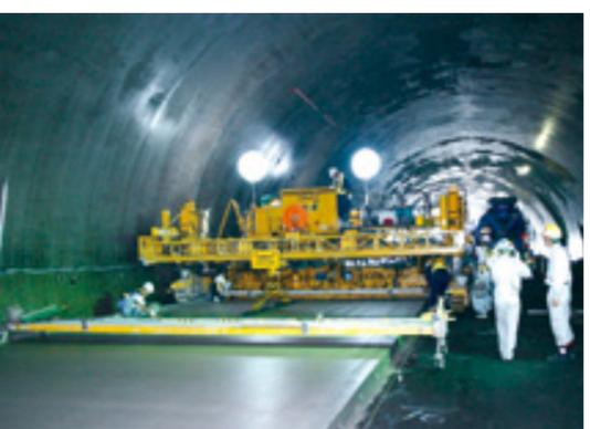
型枠を使わずコンクリート構造物を造る「スリップフォーム工法」(新名神高速道甲南トンネル舗装工事)
