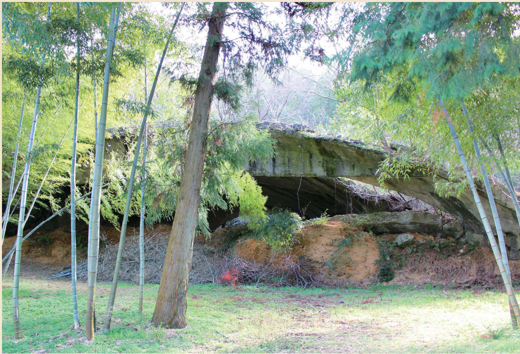
下二俣町にある小型機用の有蓋掩体壕。竹林は一部伐採されていて見学しやすくなっている(私有地のため立入禁止)。
