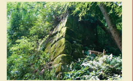
秀次館跡の高石垣。隅は算木積みで大きな石が使われている。
