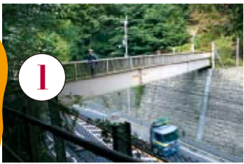
国道1号に架かる逢坂山歩道橋。
